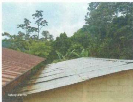
Foto1: Vista panorámica cubierta de Aula 1 y 2.
