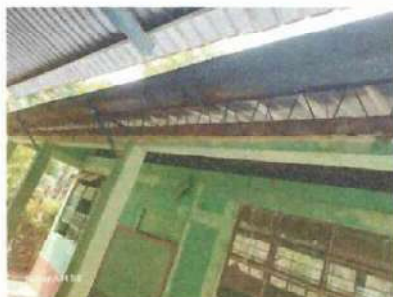
Foto 5: Canales de agua pluvial en mal estado
